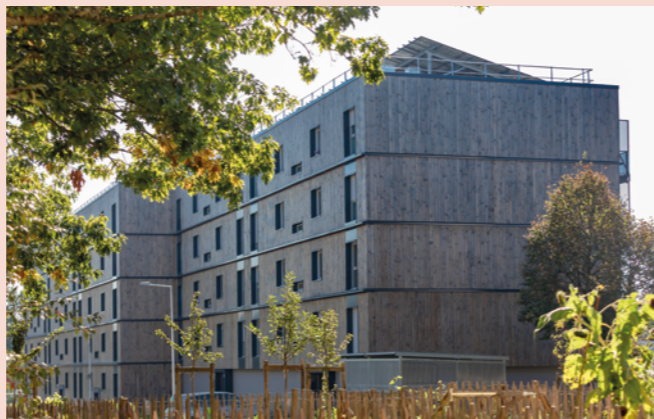
→ PNCB - Moulin du bois • Bardage Fournisseur BIA : Piveteau • Architecte : Floret-Scheide Architectes
