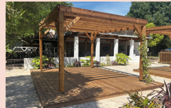
→ Pergola • Aménagement extérieur / Terrasse Fournisseur BIA : SEF Barillet
